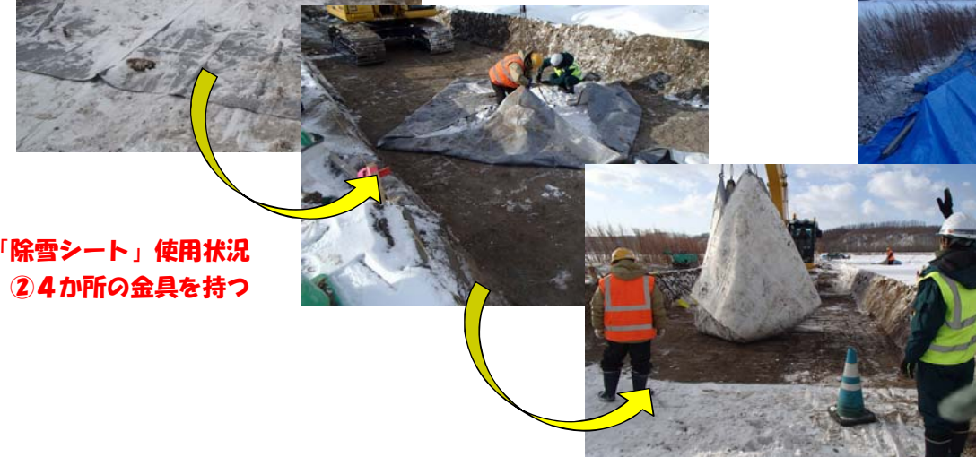
「除雪シート」使用状況 ①吊り上げて排雪する
