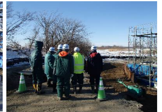
発注者による現場確認状況
