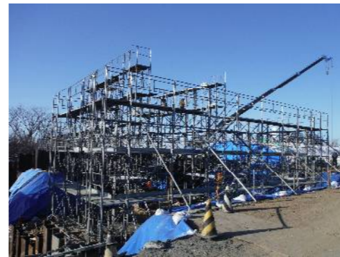
仮設工 足場及び防寒囲い施工状況
