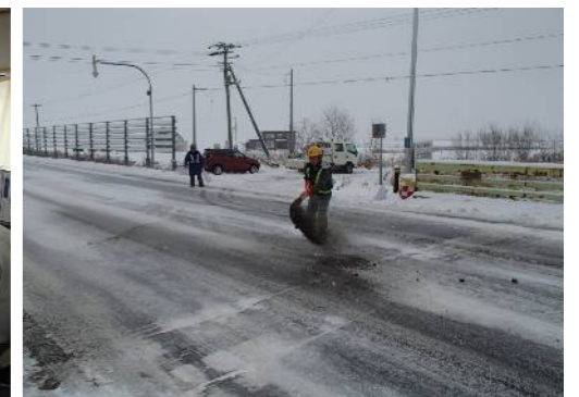
冬期路面 出入口すべり止め対策
