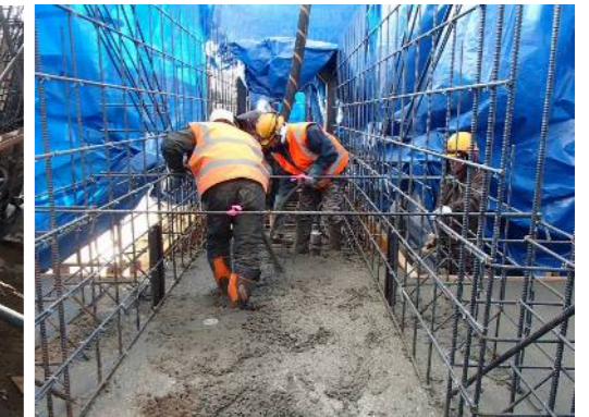
コンクリート打設状況
