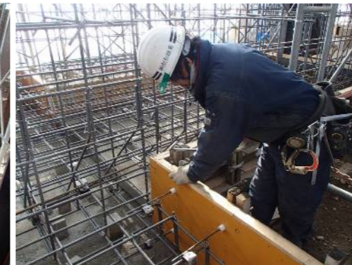
型枠設置状況
