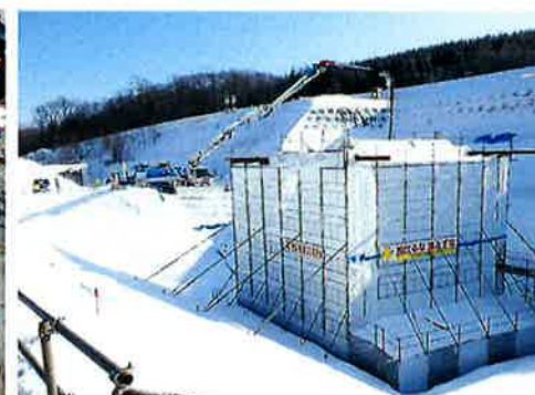
A2 躯体2回目打設部分の脱型
