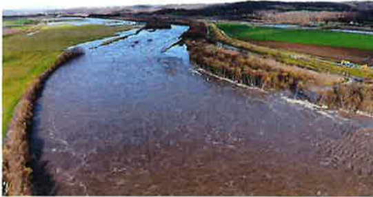
掘削箇所 11月10日 河川増水状況
