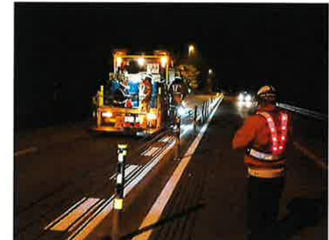
区画線施工状況
