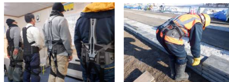
※人力による連節ブロック布設（約30kg/個）作業の軽減化
