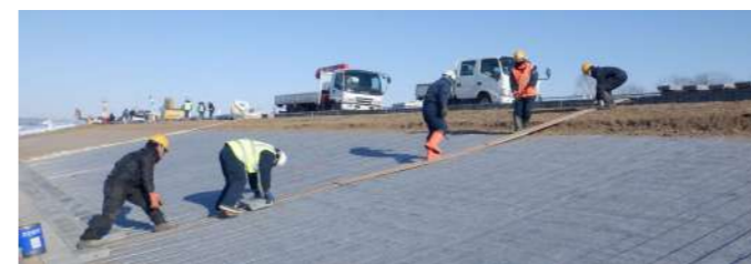
※人力による連節ブロック布設（約30kg/個）作業の軽減化
