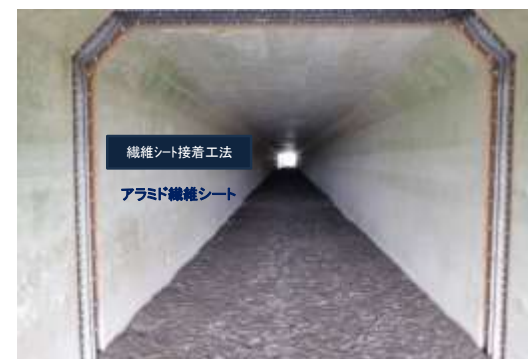
安骨樋門 函体内部
