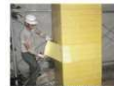
▲柱へのシートの貼付け
