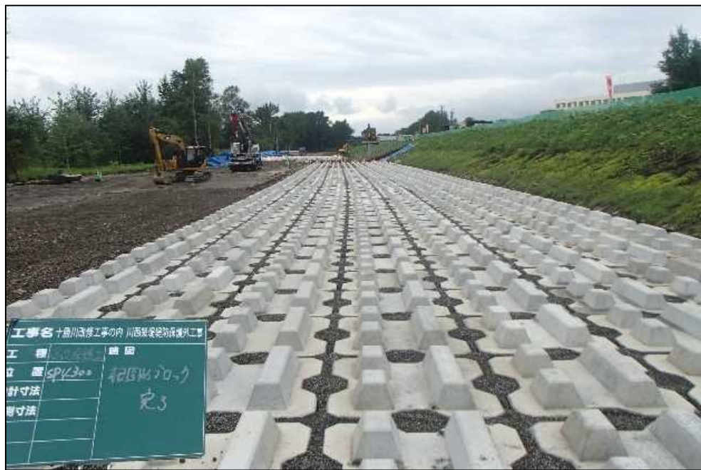
実施状況(堤防保護工)
