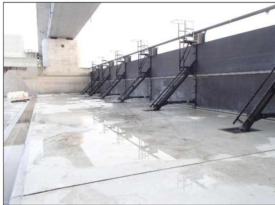
実施状況(床版工)
